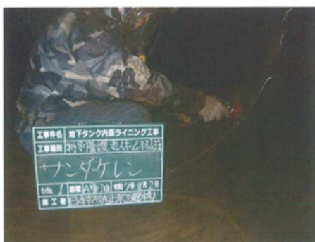
ケレン（下地処理）作業
